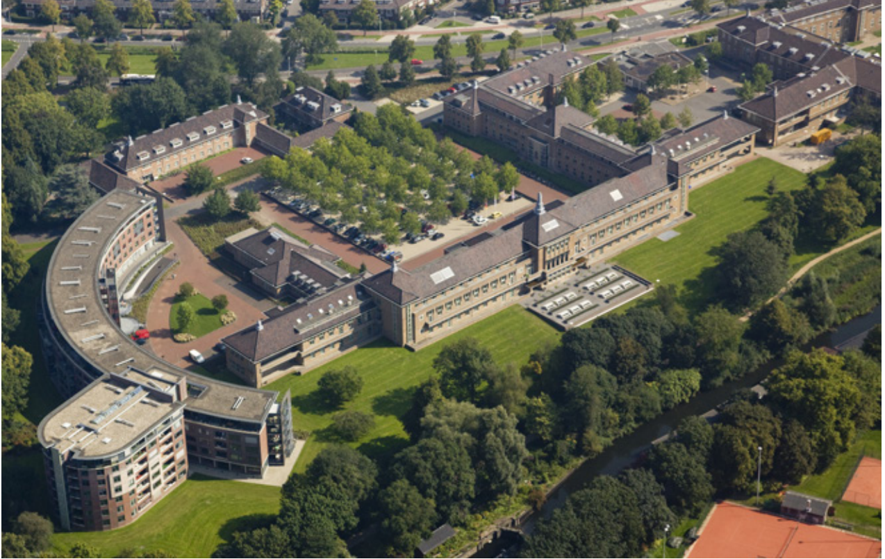
▲ Het protestants landelijk dienstencentrum - het gebouw rond de parkeerplaats - vanuit de lucht. Er liggen al een aantal jaren zonnepanelen op het dak.
